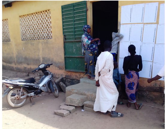
Figure 4: Inaccessibilité physique à Bassila EPP Quartier PV03
